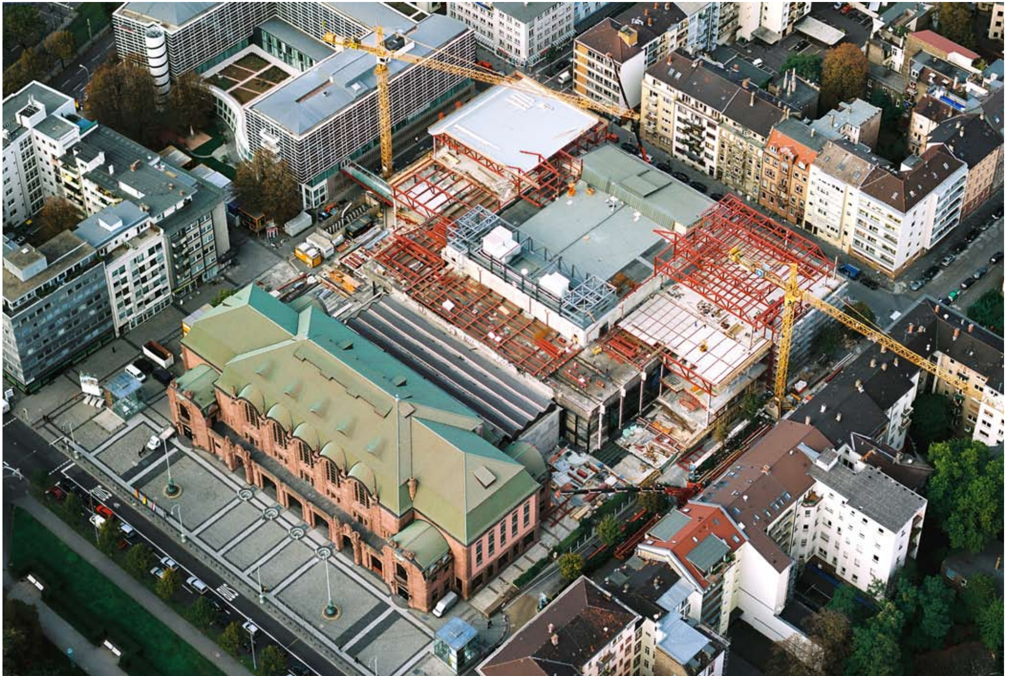
Rosengarten Mannheim, Umbau
